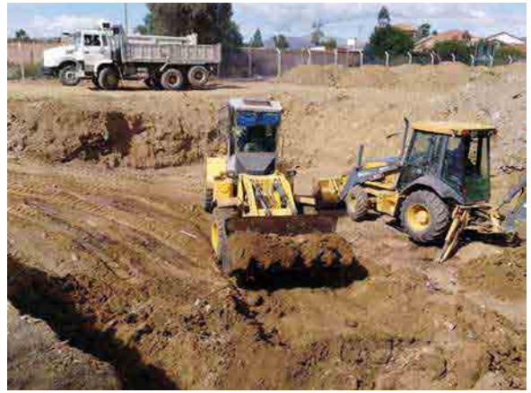
Preparación de Material para impermeabilización de los suelos
