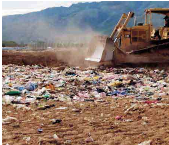
Aplicación de cobertura para compactado de residuos en la macrocelda
