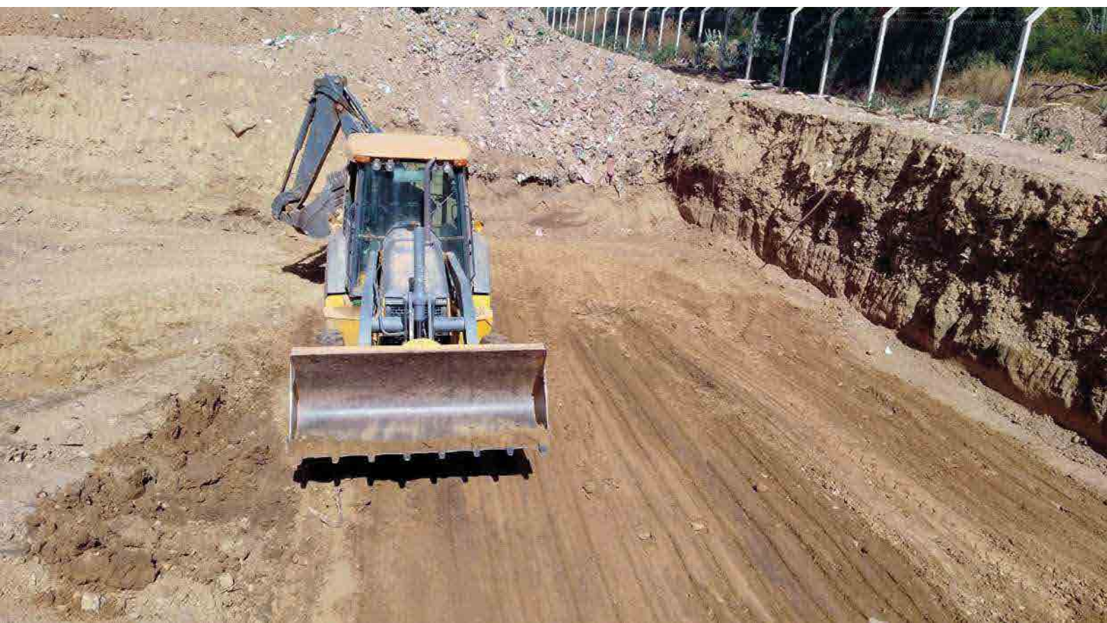
Cargador frontal para zarandear el material de cobertura
