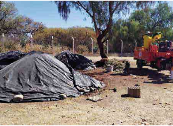
Tapado del armado de pilas
