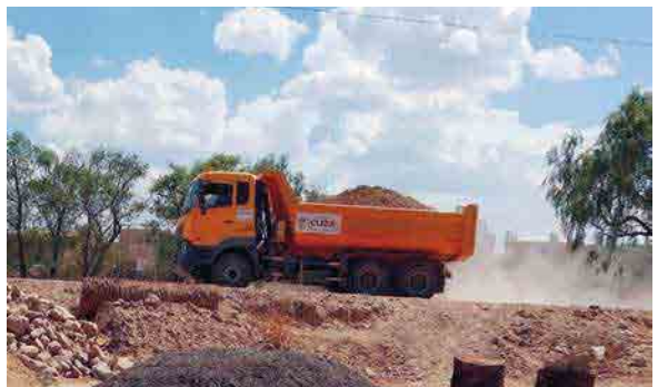
Traslado de material de cubierta a la macrocelda
