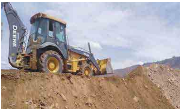
Extracción de material para cubierta de la macrocelda
