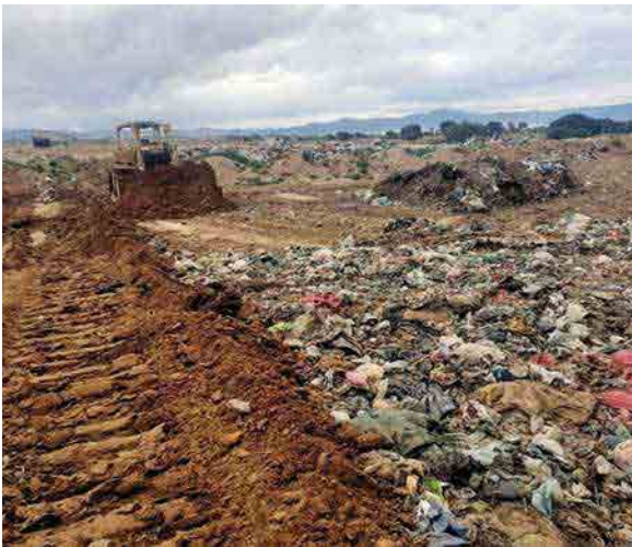
Compactado de residuos para luego de aplicar la cobertura en macrocelda
