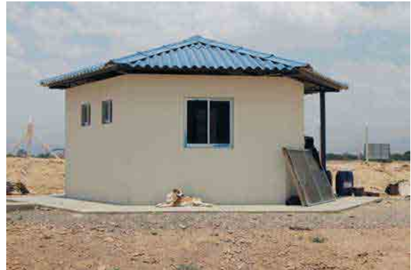
Caseta de control
