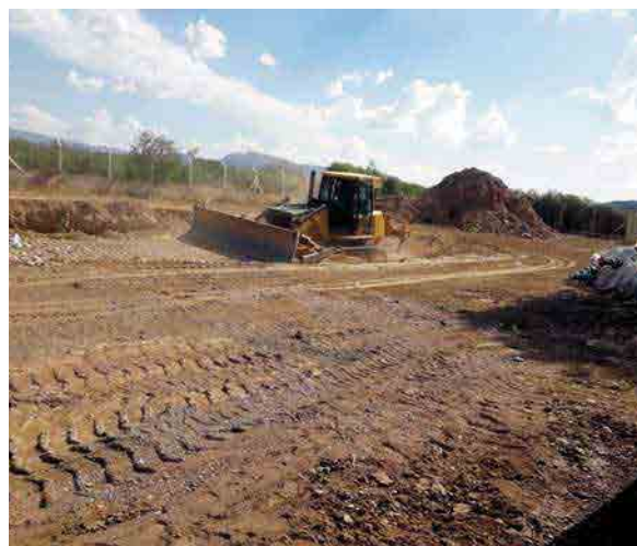
Compactación de la cobertura dentro una zanja
