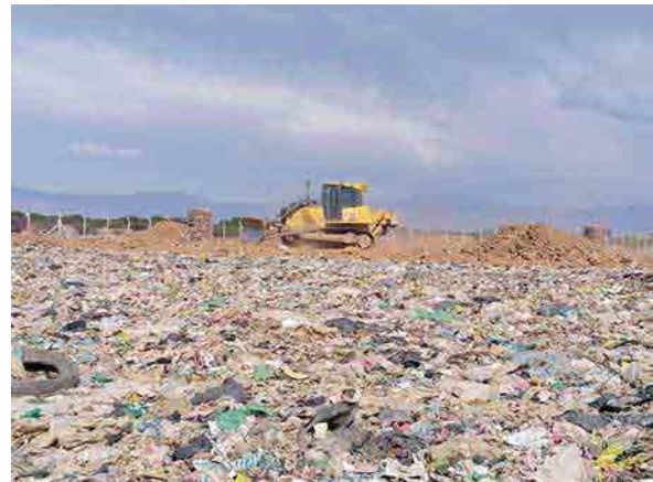
Aplicación de cobertura para evitar el esparcimiento de residuos
