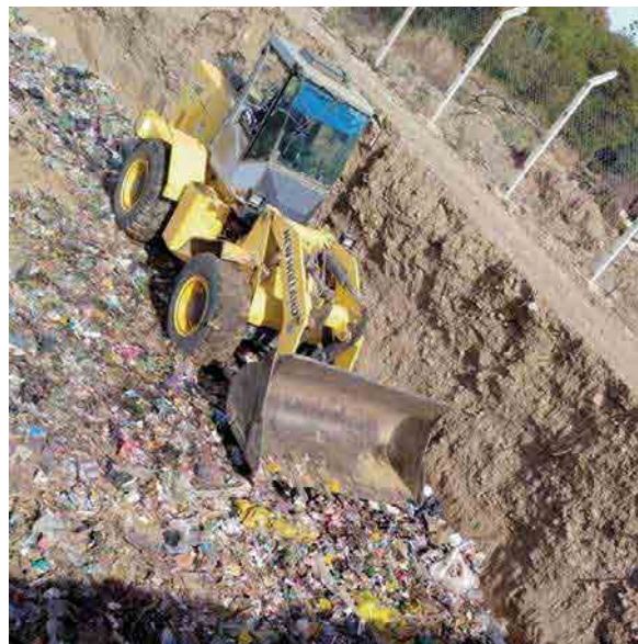
Aplicación de cobertura dentro una zanja
